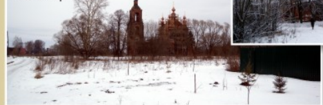
Церковь в процессе реставрации глав четверика
