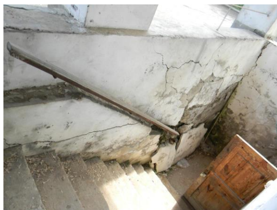
Рис. 9. Вход в подвал
