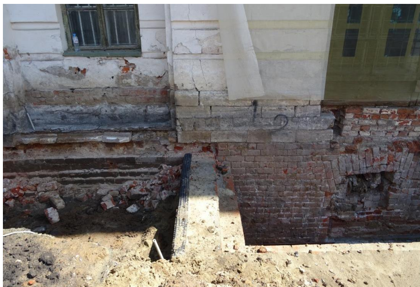
Рис. 11. Понижение уровня земли до исторической отметки и устройство гидроизоляции. Устройство смотрового прямока со световыми люками
