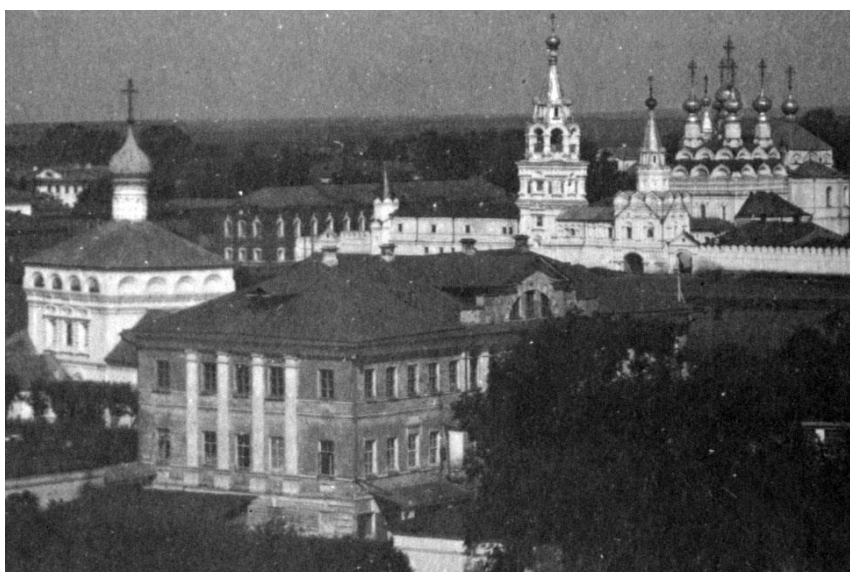
Рис. 1. Общий вид южного и фрагмент восточного дворового фасада объекта по состоянию на кон. XIX - нач. XX вв.
