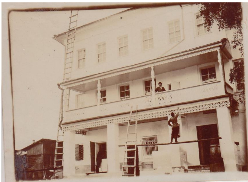
Рис. 3. Фрагмент восточного фасада объекта по состоянию на 1910 г. Общий вид исторического облика балкона
