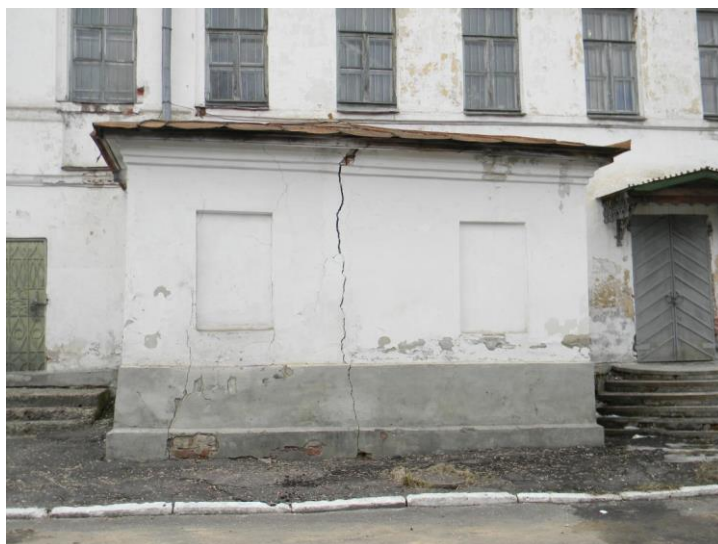
Рис. 10. Пристройка к восточному фасаду
