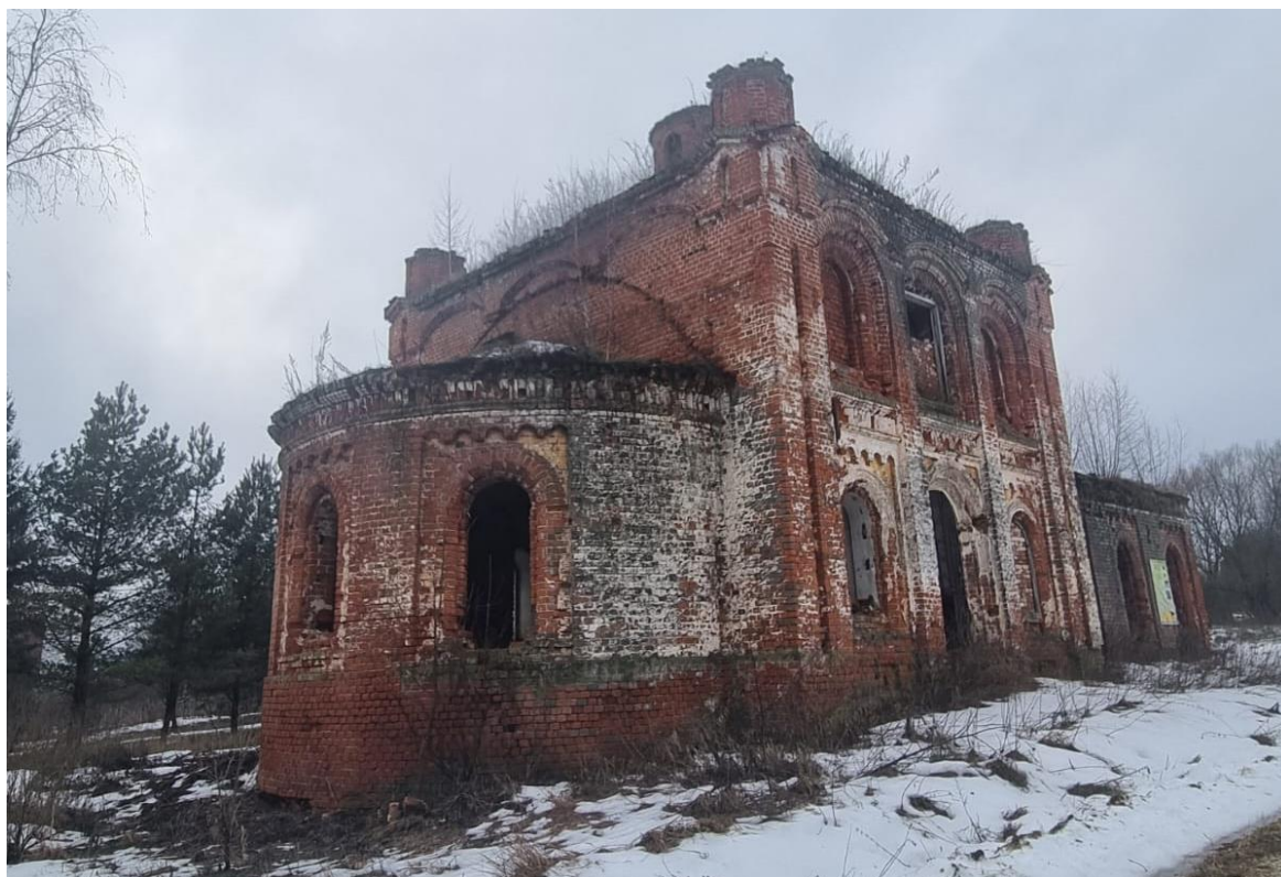
До и после выполнения противоаварийных работ
