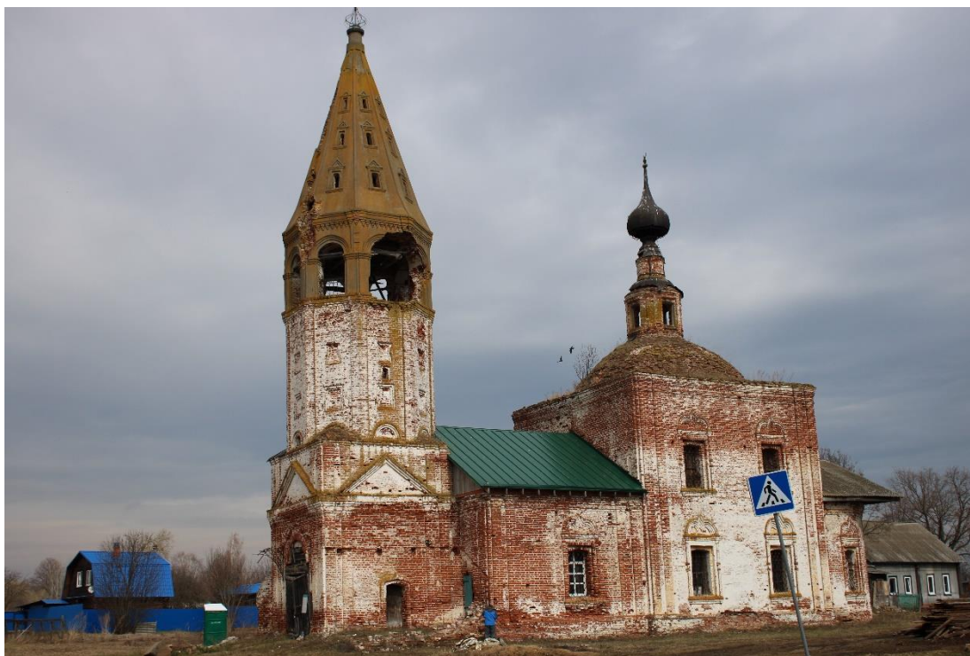
До и после выполнения противоаварийных работ
